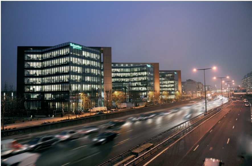
施耐德电气巴黎总部大楼：节能增效的实例展示
